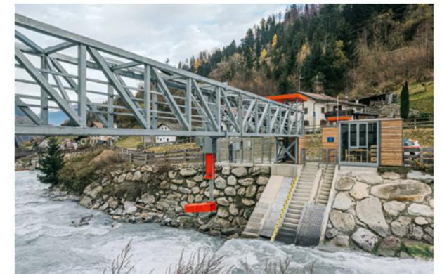
Il sistema sviluppato da Mountain-eering misura i sedimenti in un torrente di montagna.
