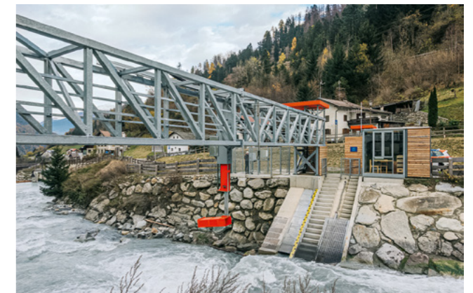
Das von Mountain-eering entwickelte System misst das Sediment im Gebirgsbach.
